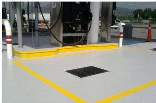
BARRERA DE VAPOR PARA GASOLINERAS
